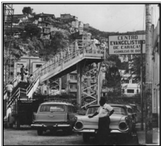
Antigua pasarela de hierro que comunicaba norte y sur, arriba barrio Hornos de Cal, los edificios pequeños al fondo son los que se aprecian en la foto superior. (Foto, años sesenta, archivo del CSB).
