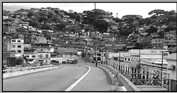
Nótese como se conservan las áreas verdes y dentro de ella la estación del Metro cable, arriba al centro. (Foto del autor, septiembre 2019).
