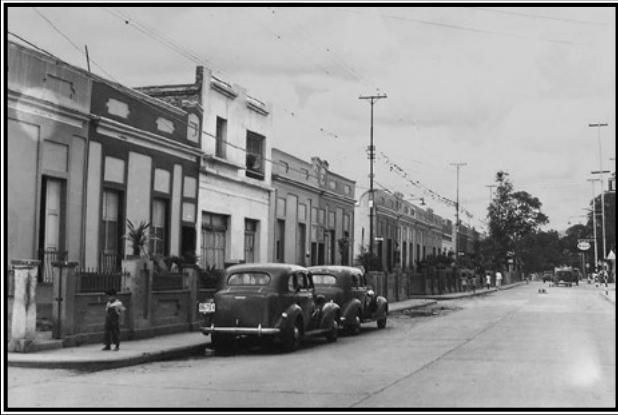
Avenida Ruiz Pineda desde el pasaje diez hasta el seis, bomba de gasolina al final a la derecha. (Foto, 1940, archivo del CSB).
