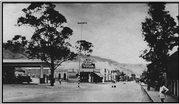
Desde el otro lado, la misma bomba de gasolina en primera plana, a través de la estructura de la bomba se puede apreciar la entrada del Puente Valency. Foto, 1940, archivo del CSB).
