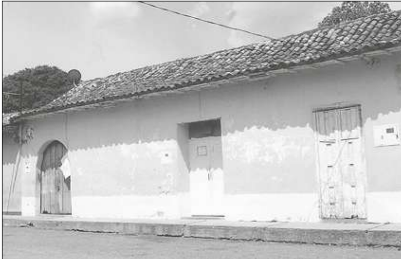
Casa Cural de Curarigua hasta 1954. Hoy esta casa está dividida en dos, una pertenece a Marcos Colón
